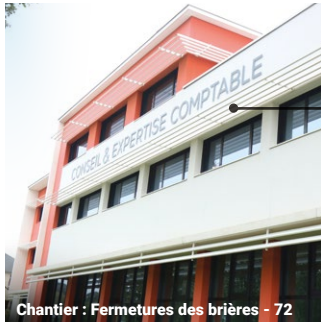
Chantier : Fermetures des brières - 72
